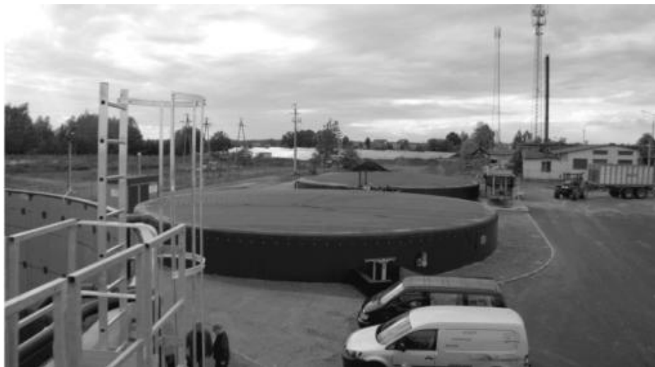
Rysunek 3 Widok zbiorników fermentacyjnych w biogazowni rolniczej w Michałowie [10]
